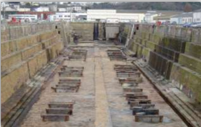
La forme n°1 avant travaux
