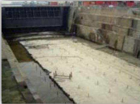
Des barres soudent le radier au rocher
