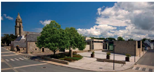
Figure 25. Plourin-lès-Morlaix (29)- Espace public de la médiathèque et de la mairie
