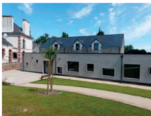
Figure 24. Kergrist (56) – Espace public de la salle multiculturelle
