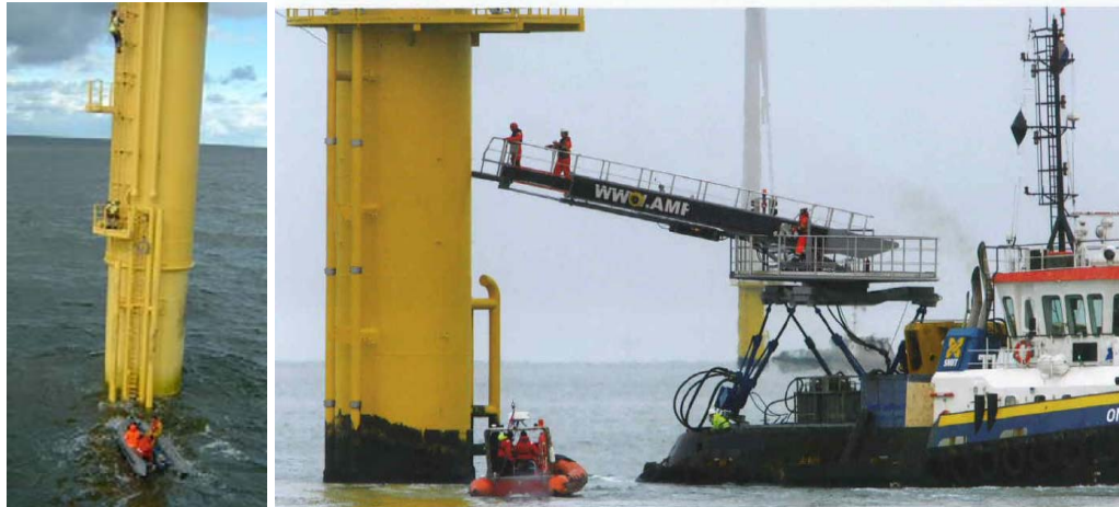
Figure 26. Exemples d'intervention sur des éoliennes fixes.
