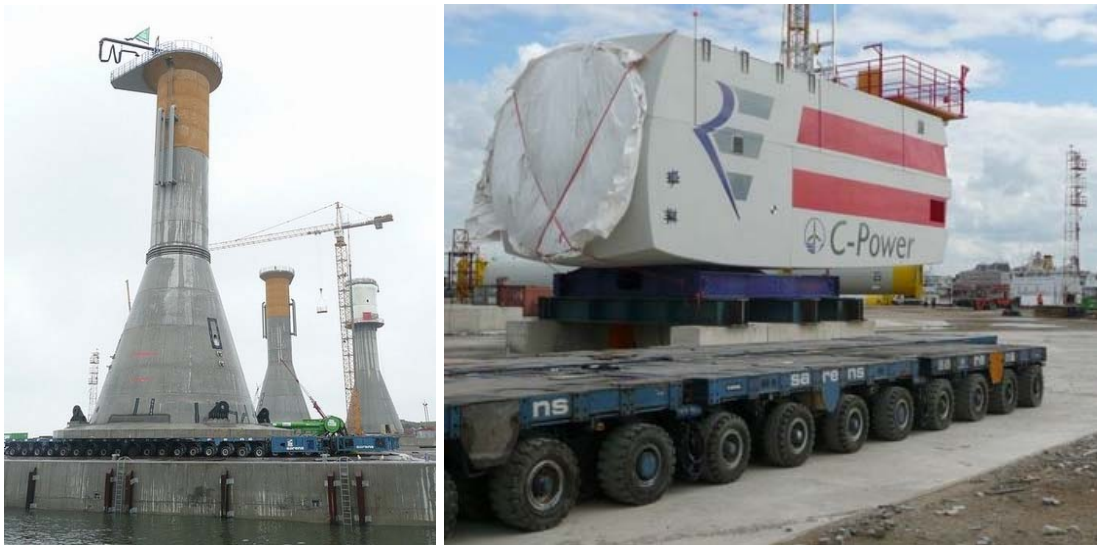
Figure 72. Construction et manutention sur le port d'Ostende (fondations de 3000 tonnes et nacelle de 315 tonnes).
