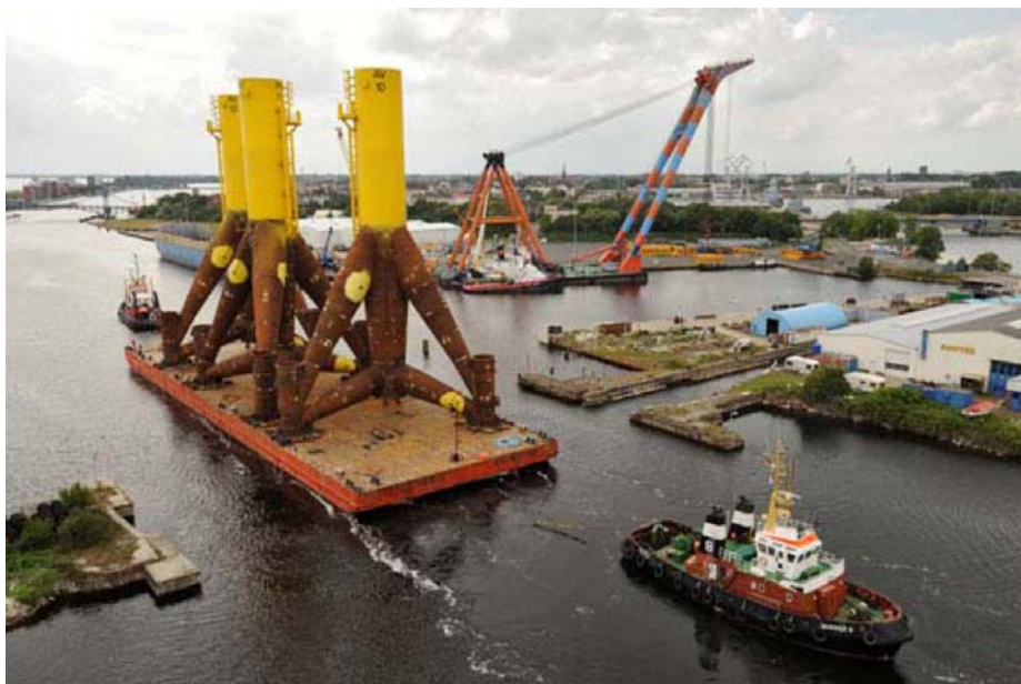
Figure 73. Transport sur barge de fondations tripodes.
