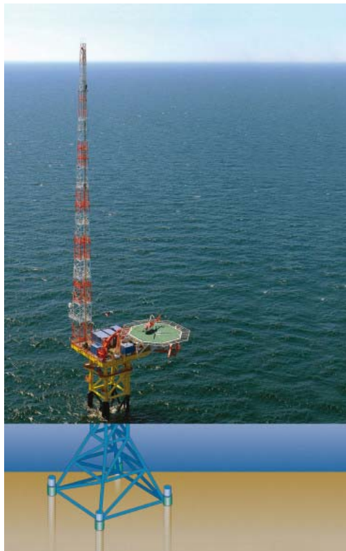
Figure 66. La plateforme FINO1 en Mer du Nord.
