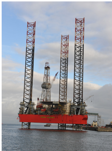
Figure 11. Navire jack up ayant servi à l'installation du danois de Horns Rev 2.
