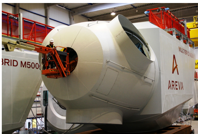
Figure 15. Assemblage des nacelles à Bremerhaven.
