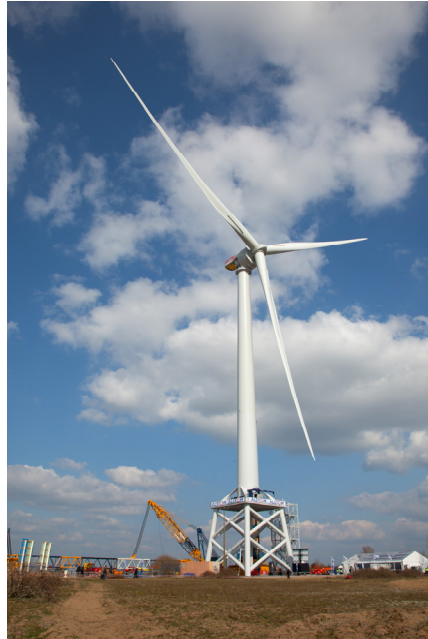
Figure 9. L'éolienne Haliade 150 d'Alstom sur le site du Carnet, à Saint-Nazaire.
