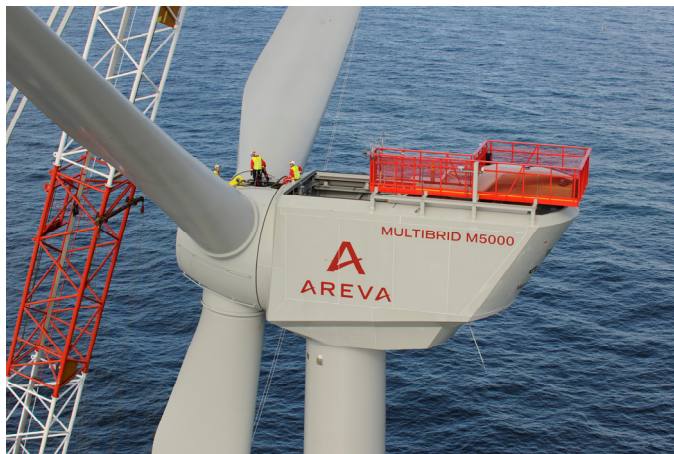
Figure 18. Installation des éoliennes sur le parc d'Alpha Ventus en Allemagne (2009).
