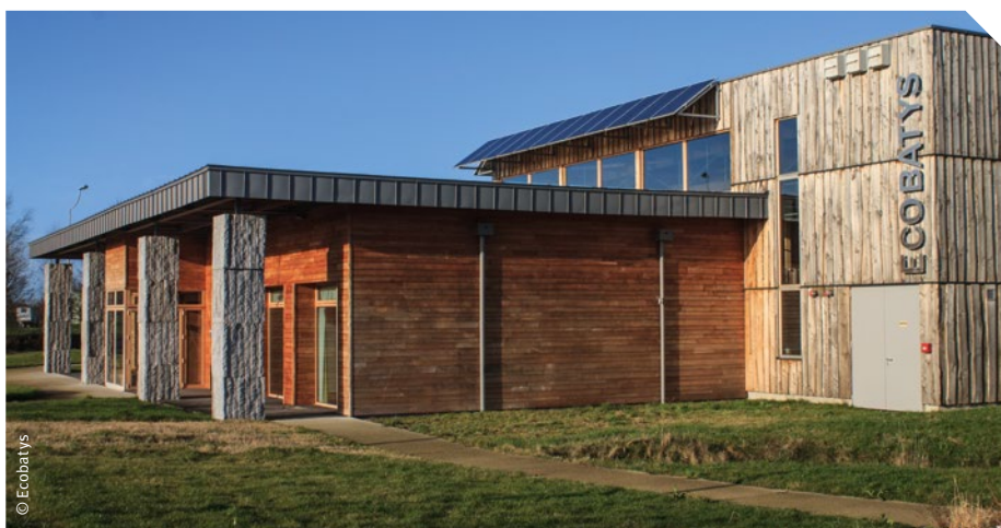
Le Pôle d'éco-construction Ecobatys situé à Saint-Étienne-en-Coglès (35) porte cette approche systémique. C'est pourquoi le CESER encourage le Conseil régional à soutenir le développement de ce pôle qui est un outil pédagogique ancré dans son territoire présentant à plusieurs égards un caractère d'exemplarité.
