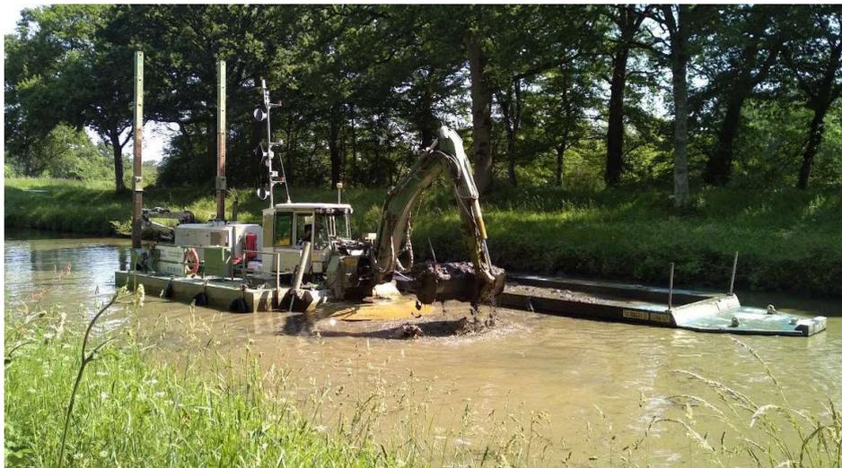
*Dragage en cours au moyen de la pelle amphibie – remplissage d'une barge*
