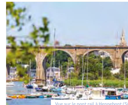
Vue sur le pont rail à Hennebont (56) © Simon Bourcier
