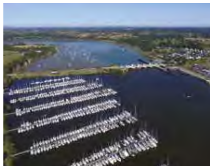
Le barrage d'Arzal (56) © Vincent Robinot
