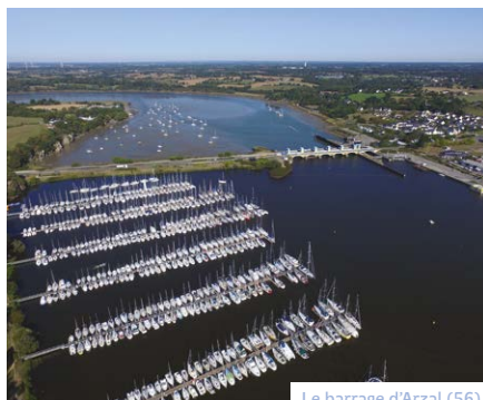
Le barrage d'Arzal (56) © Vincent Robinot
