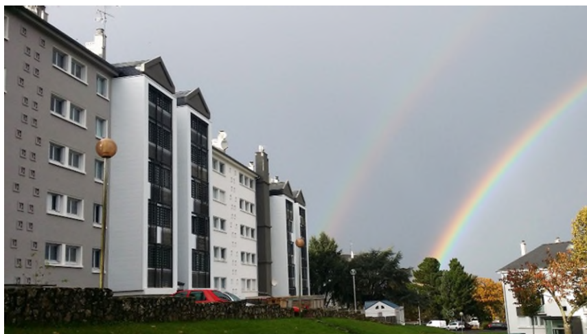
Réhabilitation énergétique de logements sociaux Crédit photo : Neotoa/Redon
