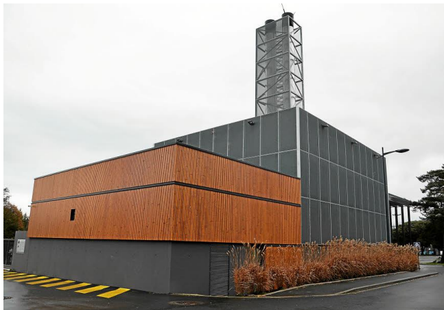
Chaufferie bois du dépôt des bus des transports urbains briochins © Saint-Brieuc Armor Agglomération
