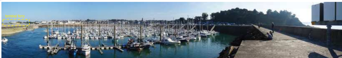
Entité 1 « digue maritime des Sablons » vue depuis l'extrémité de la digue à marée basse
