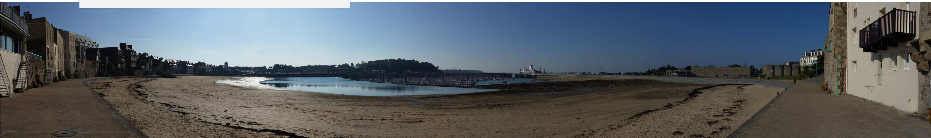
PJ4 : Sur la digue à marée haute
