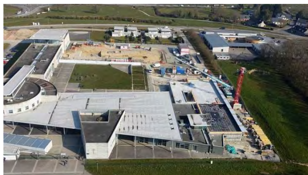
© Panoramic-Bretagne_Suivi de chantier extension au Lycée Jean Brito, Bain-de-Bretagne
