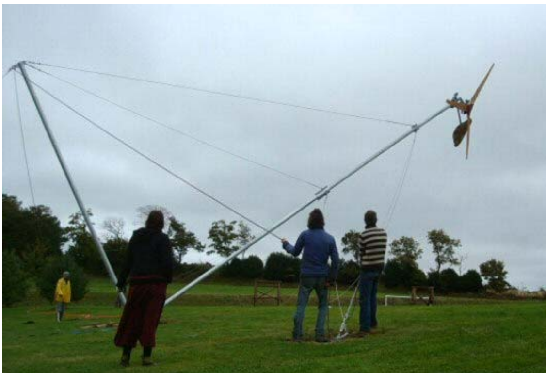
Le montage "associatif" d'une petite éolienne en auto-construction La Vraie-Croix, Morbihan, 2008.
