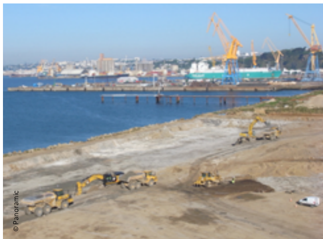
Un programme de travaux ambitieux, un engagement financier important
