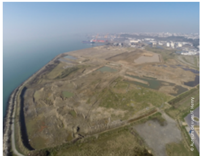
L'aménagement du polder 124 permettra d'augmenter de manière importante la surface portuaire
