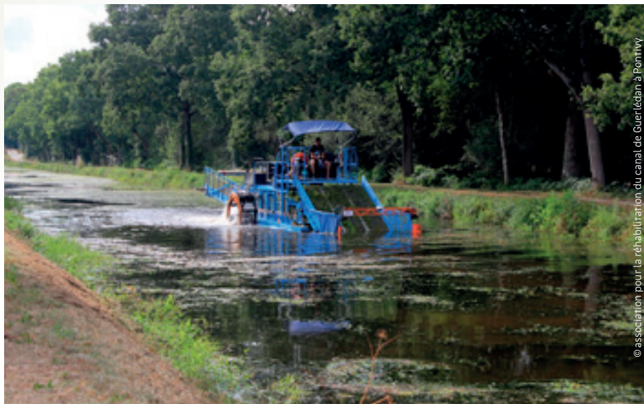
Opération de faucardage de l'élodée sur le canal.
