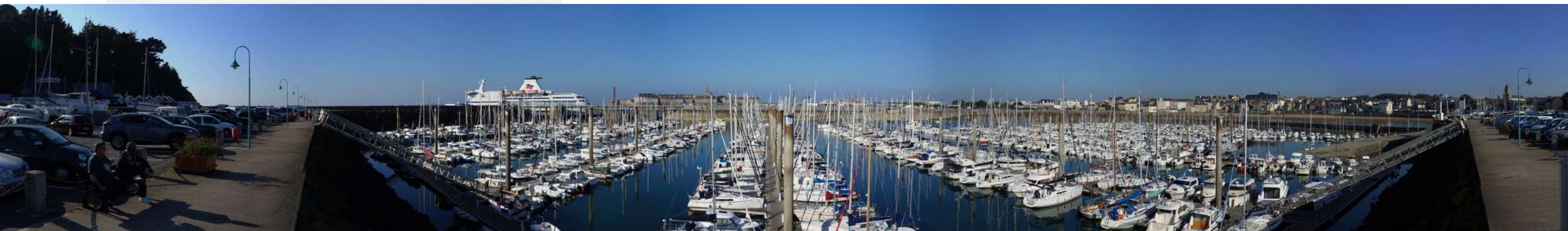
PV3a : Au pied de la rampe à marée basse avec un ferry
