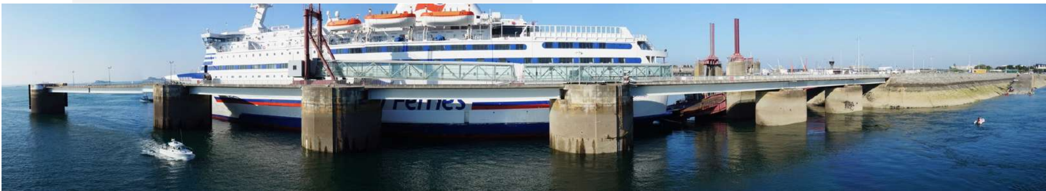
PV1a : Depuis le bout de la digue à marée basse
