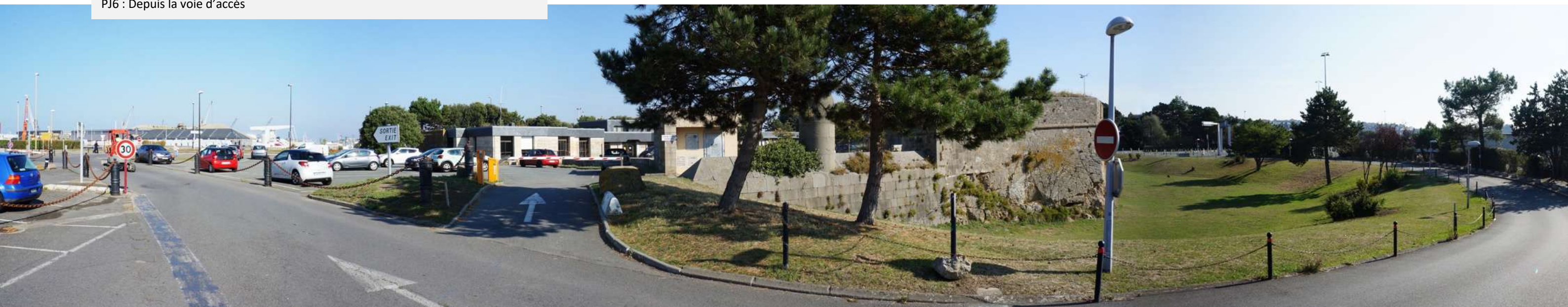
PJ6 : Depuis la voie d'accès
