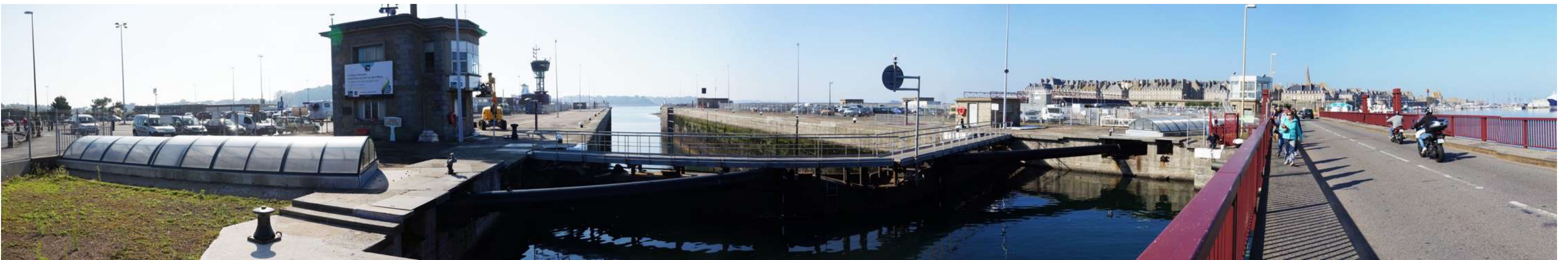
Pont fermé en regardant vers Intramuros :
