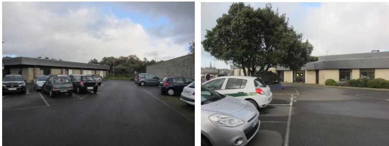
La seconde et troisième strate de construction datent des années 1970 / 1980
