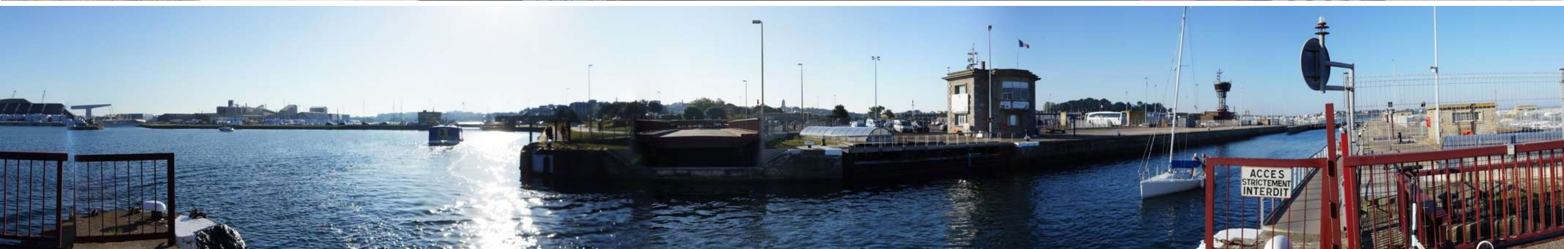
PV6a : Pont ouvert en regardant vers le terminal
