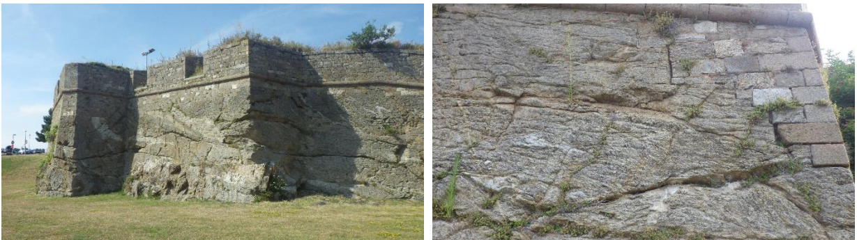
Figure 14 : Vues sur le rempart
