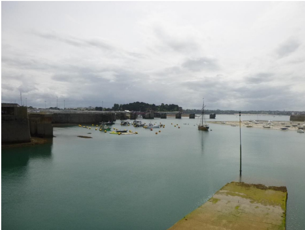
Photographie de l'environnement en direction du giratoire du Naye
