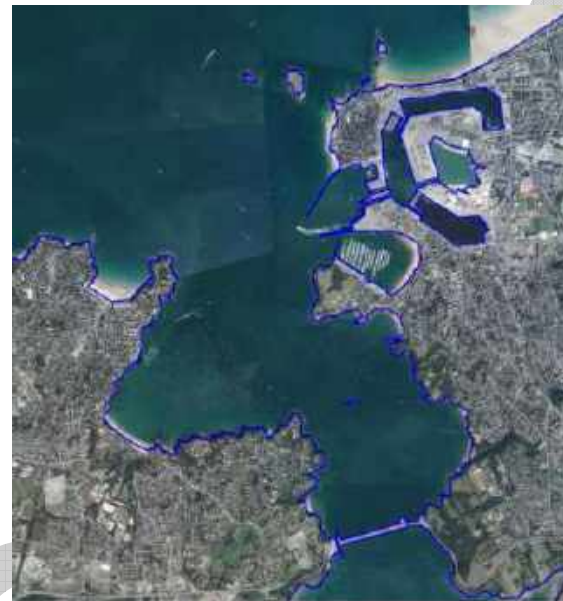
Figure 135 : Aménagement du port en 2010. Source : Rapport IDRA
