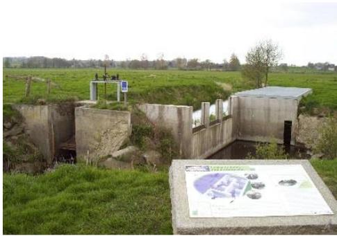
**PHOTO 23 : OUVRAGE DES LOGES (VANNAGE ET PASSE À POISSONS)-(CC PDBMSM)**
