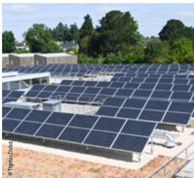
La toiture du service de restauration est végétalisée et couverte de 500m<sup>2</sup> de panneaux photovoltaïques.
