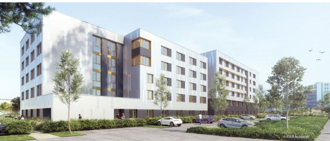
Façade sud des nouveaux internats
