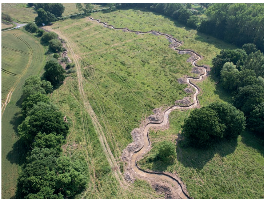
Après les travaux de renaturation, le tronçon du Guinguenoual a retrouvé la sinuosité naturelle de son lit mineur et s'insère dans un écrin vert de zones en herbe et de haies bocagères. Crédit photo : Dinan Agglomération.
