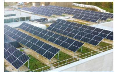
La toiture du service de restauration est végétalisée et couverte de 500 m<sup>2</sup> de panneaux photovoltaïques.
