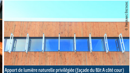
Apport de lumière naturelle privilégiée (façade du Bât A côté cour)
