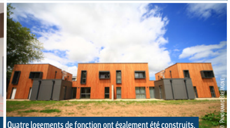
Quatre logements de fonction ont également été construits.
