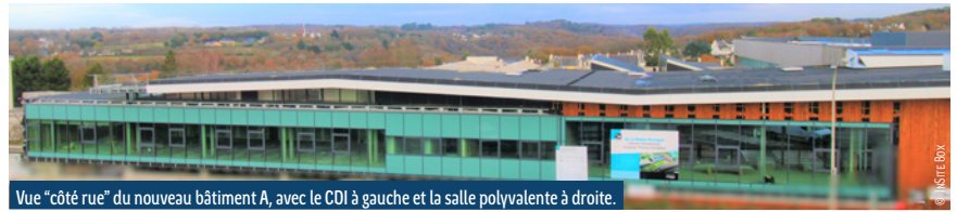
Vue "côté rue" du nouveau bâtiment A, avec le CDI à gauche et la salle polyvalente à droite.
