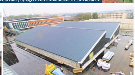
Les ateliers en travaux. Au second plan le nouveau bâtiment A
