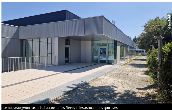
Le nouveau gymnase, prêt à accueillir les élèves et les associations sportives.
