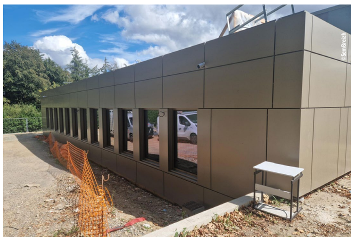
Les ateliers prennent forme. Zoom sur la façade sud et sur les intérieurs avec la cuisine familiale pédagogique.
