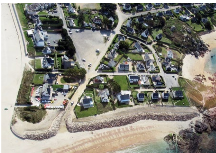
➤ Enrochement installé en 2017 le long de la Plage de la Grève Rose à Trégastel, suite aux dégâts causés par la tempête en 2008.
