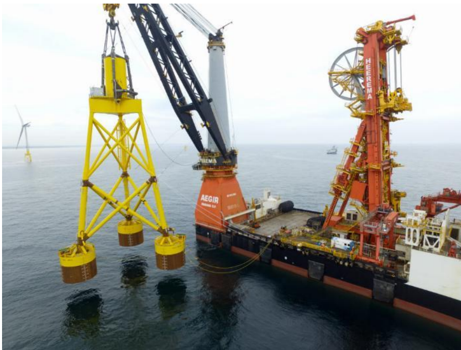
Figure 1-12: Installation d'un jacket à 3 jambes et aux ancrs à suction en mer [SPT Offshore, 2024]
