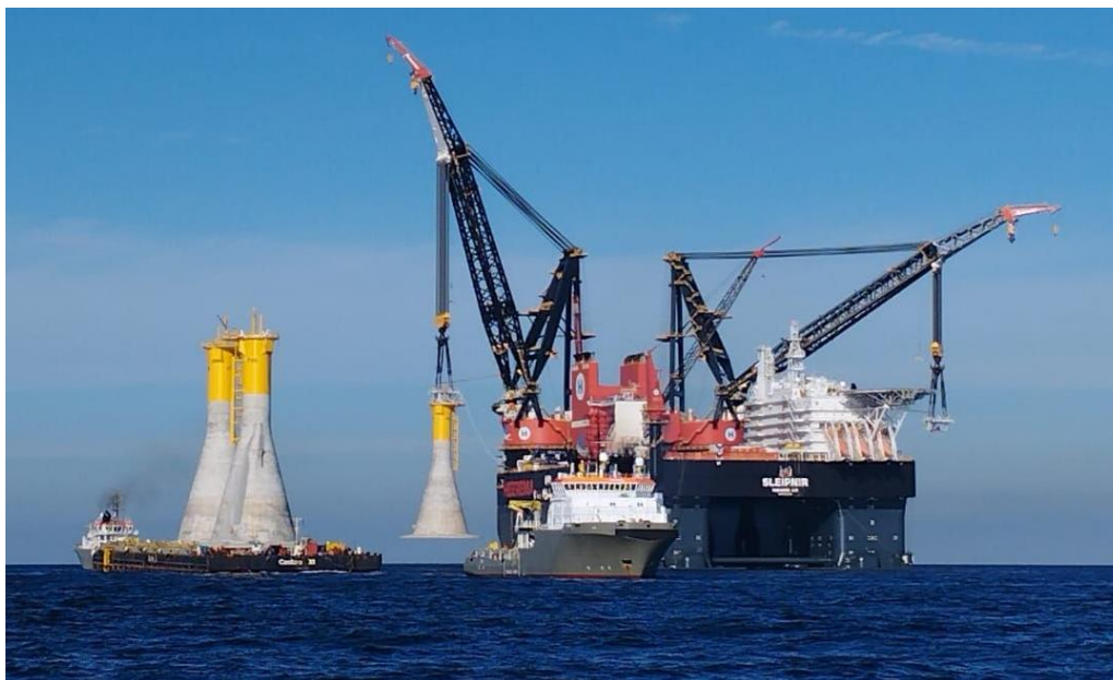
Figure 1-13: Installation des fondations gravitaires sur le parc éolien de Fécamp [Project Cargo Journal, 2022]
