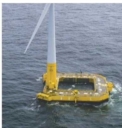
Barge : BW Ideol au Croisic (2MW)
