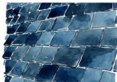
L'ardoise impose une pente minimum.
