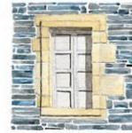
L'encadrement de la fenêtre est en saillie par rapport au reste du mur. Celui-ci était donc destiné à être enduit.
