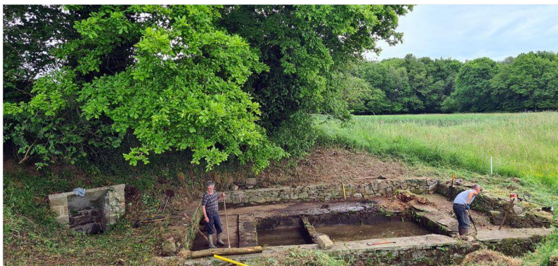
Rénovation du lavoir du Petit Saint-Brieuc © Association Culture et Patrimoine
