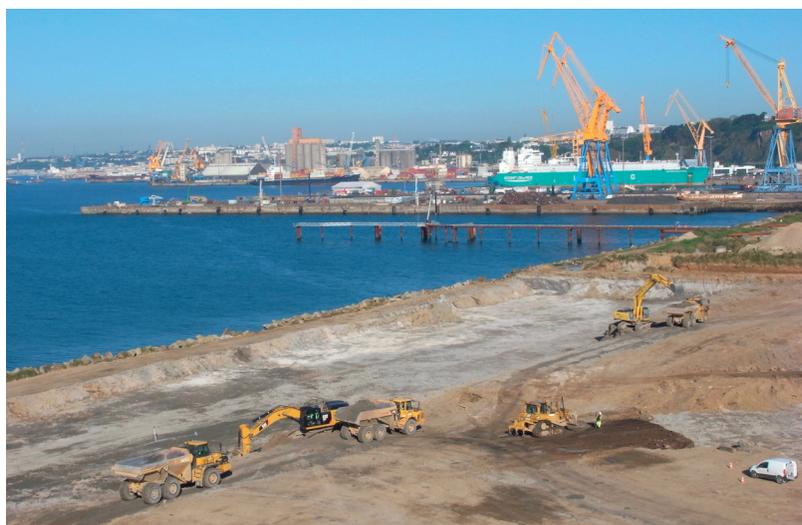
du polder, et la création de quais et d'espaces de manutention adaptés aux lourdes charges des éoliennes. Dans le même temps, des travaux de modernisation vont permettre d'adapter le port au tirant d'eau de navires toujours plus grands, avec le dragage des sédiments et leur valorisation à terre dans un nouveau polder, afin d'approfondir le chenal d'ac-
