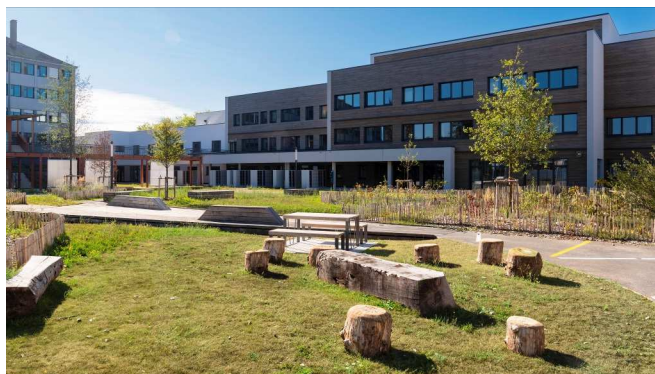
Le réemploi a été privilégié sur le chantier : le bitume a été transformé en pas japonais et des arbres en mobilier extérieur.
