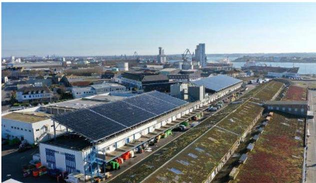
Après 6 mois de travaux, la centrale photovoltaïque fonctionne : la production annuelle, estimée à **740 MWh**, équivaut à **12% des consommations du port de pêche** (hors réparation navale).
