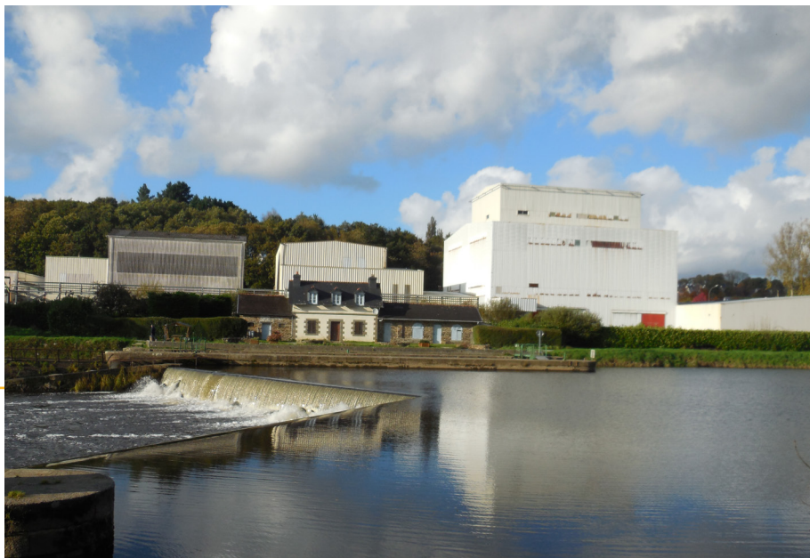
Châteaulin écluse de Coatigrac'h, laiterie Gilap
